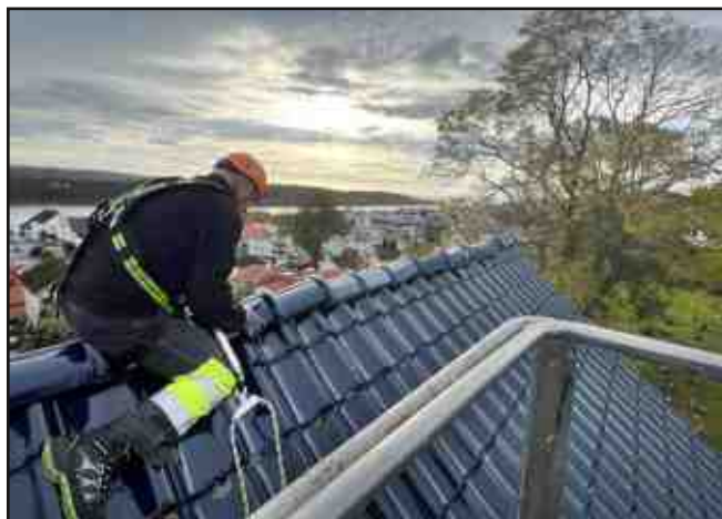
Morten retter opp takstein på kirketaket etter stormen nå i oktober. Foto: Astrid Thomasberg.
